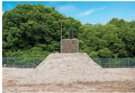
ガス抜き設備(縦集水人孔)
